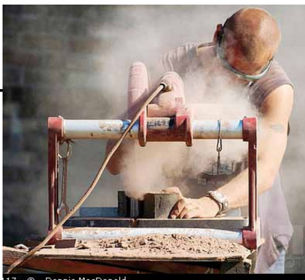
RIESGO VISIBLE. Los albañiles están expuestos a partículas de sílice, talco, mica y calcita. Su exceso puede causarles enfermedades graves.
